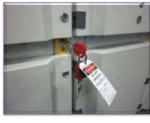
รูปแสดงการตัดแยกไฟฟ้าภายในอาคาร (Substation)
