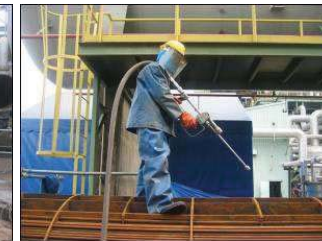
ลักษณะการทำความสะอาดด้านนอก Tube โดยการขึ้นไป Clean ด้านบน
