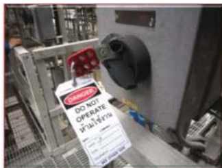
รูปแสดงการตัดแยกไฟฟ้าที่วิศวกรทำงาน
